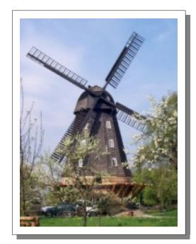
Ländern am Mittelmeer. Bei der Turmwindmühle konnte man die Flügel meist nicht in den Wind drehen. Die Mühle musste daher schon beim Bauen nach der Hauptwindrichtung ausgerichtet werden.
